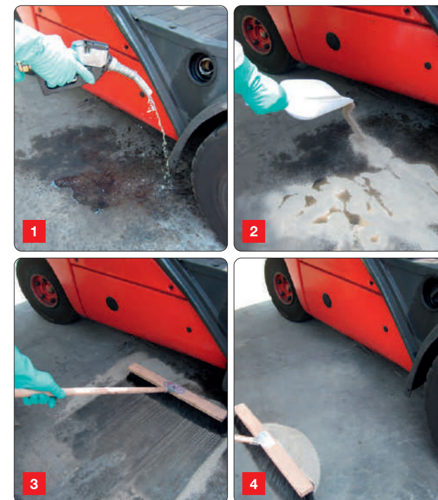
ESEMPIO DI ASSORBIMENTO CON POLVERE AL SUOLO: SVERSAMENTO DA IDROCARBURI EXAMPLE OF ABSORPTION IN CASE OF OIL SPILL: GRANULATES ON THE SOIL HYDROCARBONS
