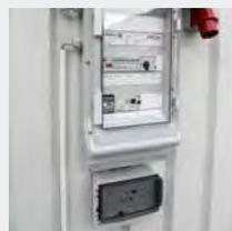
An der Außenseite der Seitenwand ist ein Sicherungselement mit einer Kontrolleinheit für die Gaswarnanlage gemäß TRGS 510 montiert.
