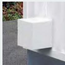
An der Außenseite der Seitenwand ist ein explosions- und witterungsgeschützter Lüfter im Dauerbetrieb gemäß TRGS 510 angebracht.
