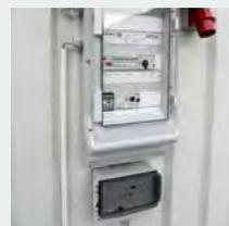
An der Außenseite der Seitenwand ist ein Sicherheitselement mit einer Kontrolleinheit für die Gaswarnanlage gemäß TRGS 510 montiert.
