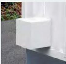
An der Außenseite der Seitenwand ist ein explosions- und witterungsgeschützter Lüfter für den temporären Betrieb gemäß TRGS 510 montiert.
