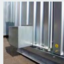
An der Außenseite der Seitenwand ist ein explosionsgeschützter Lüfter im Dauerbetrieb angebracht.
