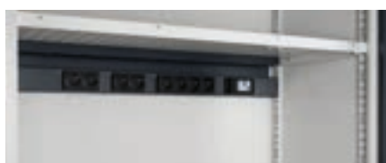
Aplicación canaleta eléctrica en la parte inferior del estante-panel perforado
