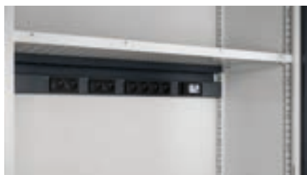
Aplicación canaleta eléctrica en la parte inferior del estante-panel perforado
