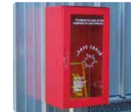
Armario para extintor
