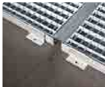
Detalle fijado lateral y perfil de unión
