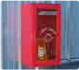
Armario para extintor
