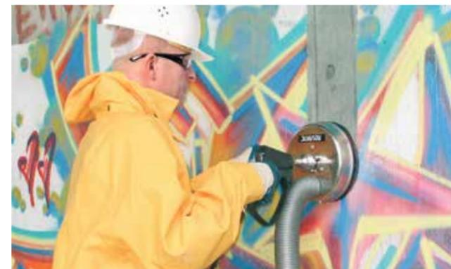
Brazo rotor, puede soportar hasta 500 bar.
