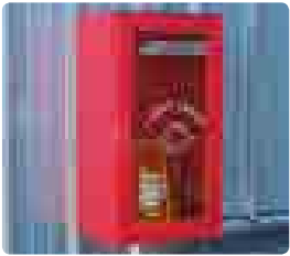
Armario para extintor
