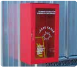
Armario para extintor
