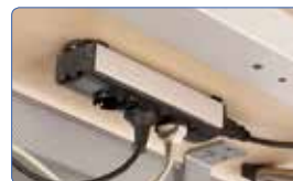
Toma de conexiones
