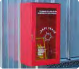
Armario para extintor
